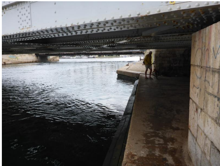
Nous passons sous un pont
