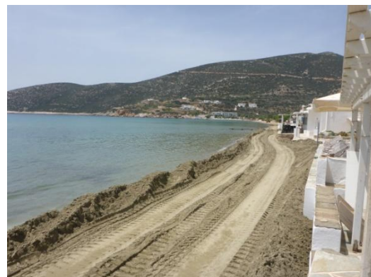
La plage en travaux
