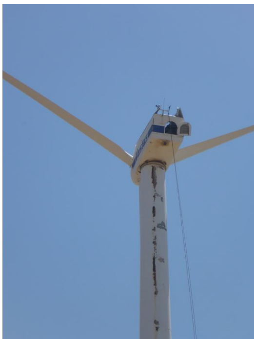
Un homme est en haut et répare l'éolienne
