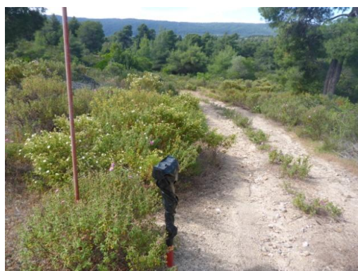
Bouche à incendie
