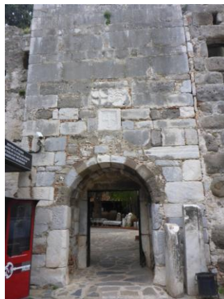
L'entrée du château
