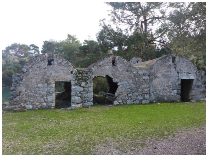
Les ruines du grand bâtiment
