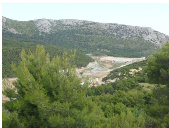
Le barrage en construction
