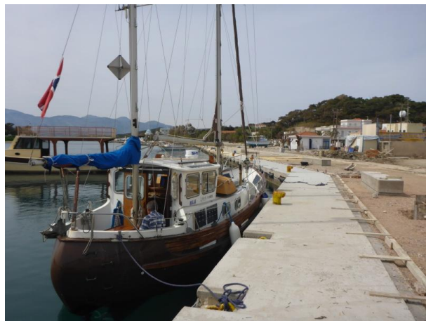
Maja au quai en travaux
