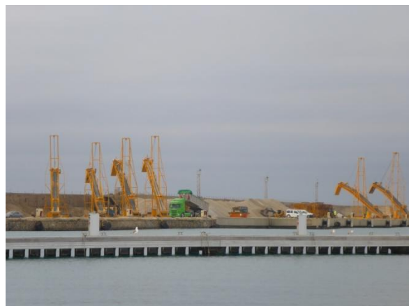
Le bout de la digue
