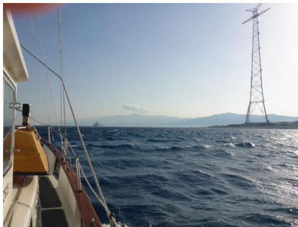
Un des deux pylônes, celui côté sicilien. Il y a le même de l'autre côté.
