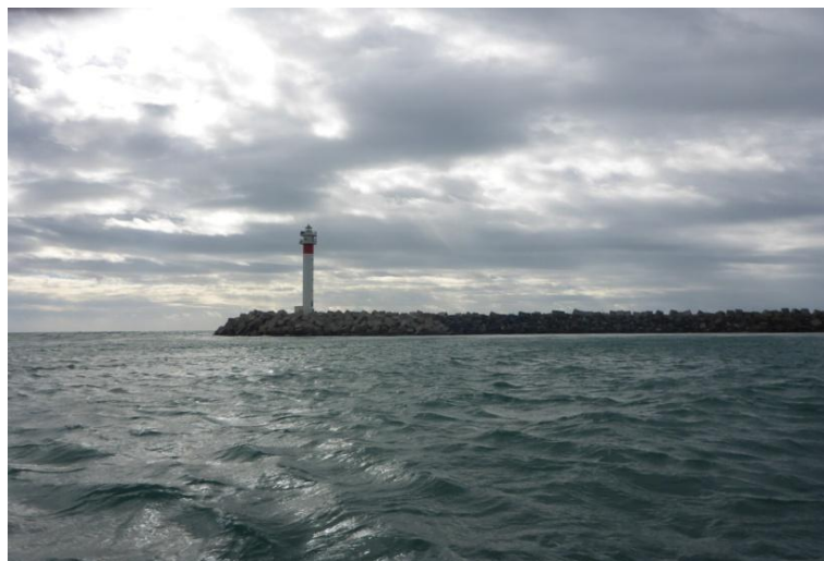
Ouf ! On est à l'abri de la longue digue
