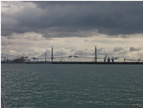
Le pont en construction. Cadiz
