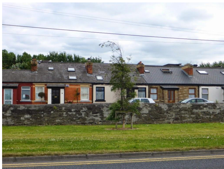
Les petites maisons le long du port. Dublin
