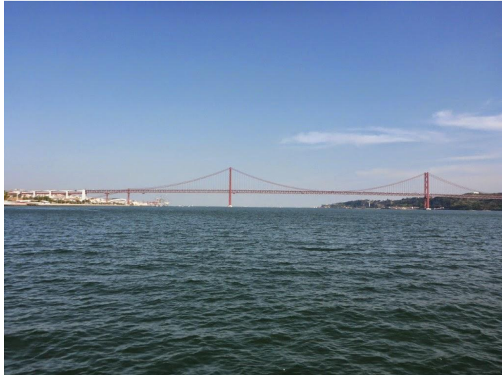
Arrivée à Lisbonne. Pont 25 do Abril
